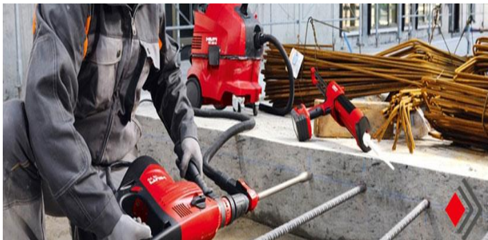
تصویر 1. (نحوه غرس با استفاده از مواد پایه سمنتی)
